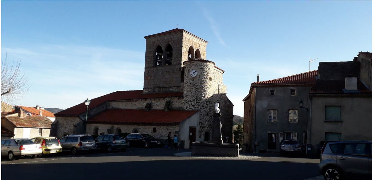
Façade nord / ouest
