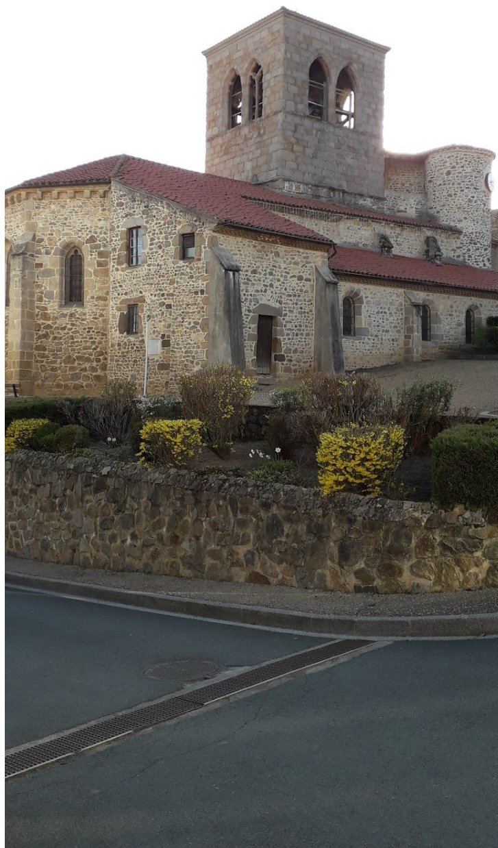
Façade nord / est
