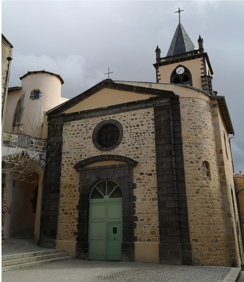
Porte d'entrée principale
