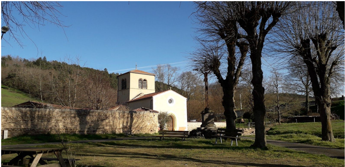
Façades nord / ouest Crédit photo : UCA / MI DPEC ACTT groupe 1 2019-2020
