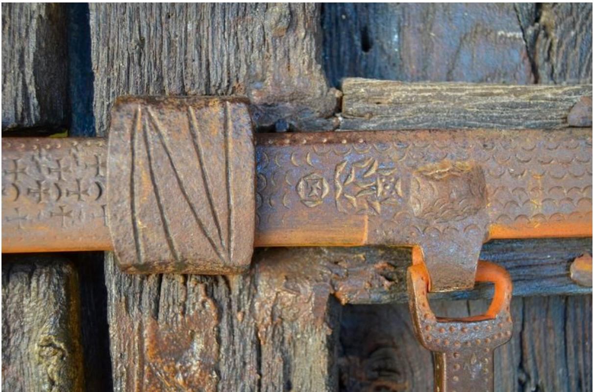
Porche occidental, détail, Ministère de la Culture (France), Médiathèque de l'architecture et du patrimoine, diffusion RMN-GP
