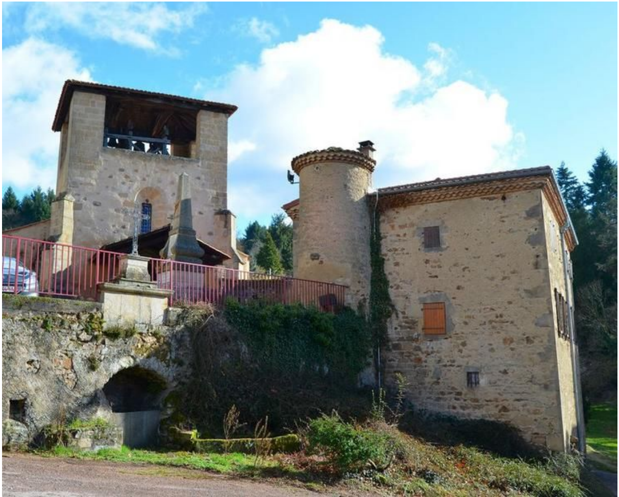
Ensemble ouest, vue générale, Ministère de la Culture (France), Médiathèque de l'architecture et du patrimoine, diffusion RMN-GP
