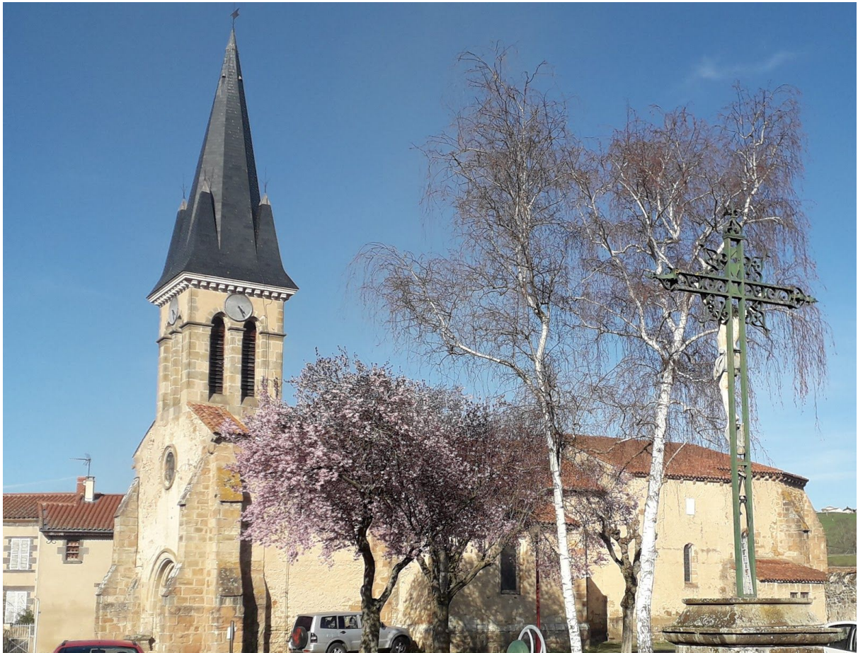
Façades sud / ouest
