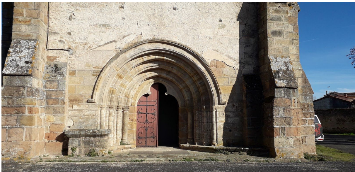
Porte d'entrée, façade ouest
