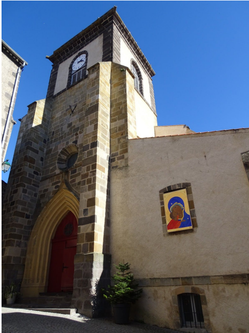
Vue de la façade
